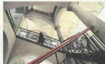
Steht wie seit 1877: Über dieses Treppenhaus werden die Abteilungen erreicht, die neben den Ausstellungsräumen ins Gebäude kommen.
